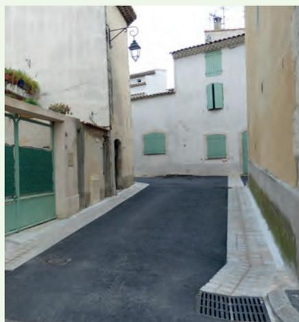
Rue du Puits neuf et voies attenantes : réalisation des caniveaux et trottoirs en pierres et béton désactivé après enfouissement des réseaux aériens.
