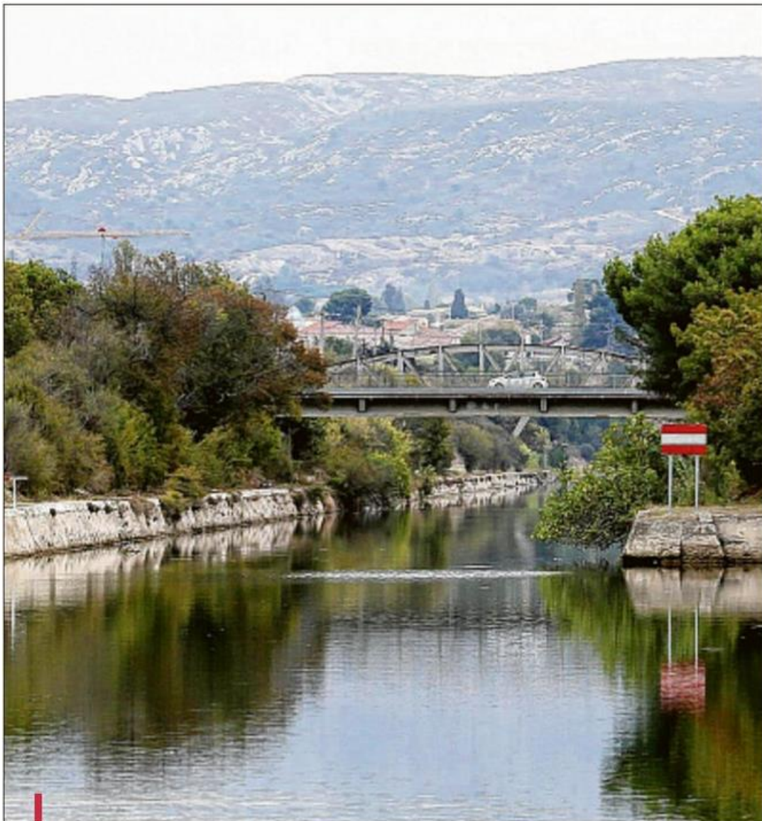
Au bout du canal du Rove, le tunnel. C'est par ici que devraient transiter les eaux pompées dans la mer, côté Estaque. Mais l'Etat a indiqué en juillet son refus de financer ce projet. / PHOTO SERGE GUÉROULT
