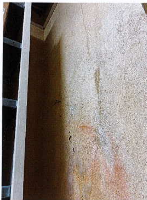
Traces d'humidité sur les murs du magasin n°3
