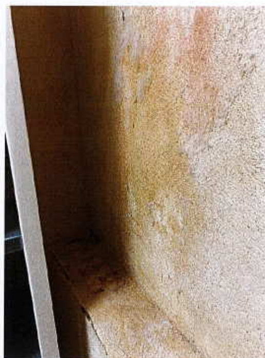
Traces d'humidité sur les murs du magasin n°3
