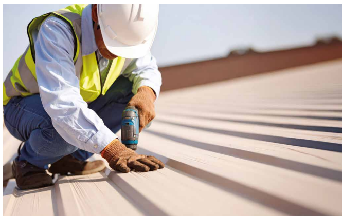
Opération : Étanchéité de la toiture de différents bâtiments communaux. Coût prévisionnel : 143 700 €
