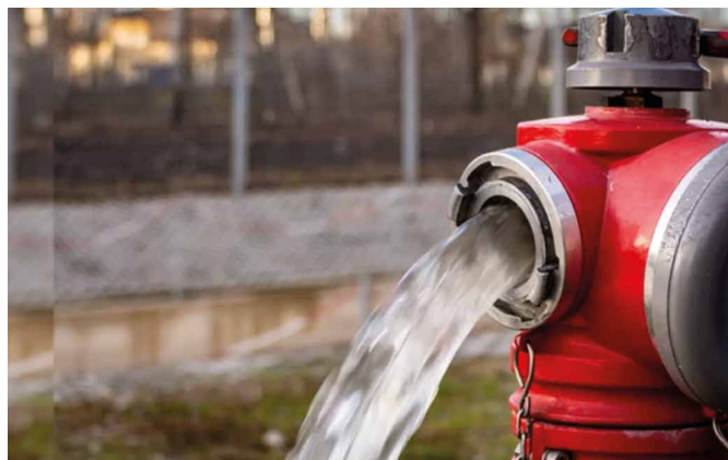
Opération : remplacement de poteaux incendie dans la commune. Coût prévisionnel : 25 200 €
