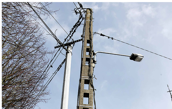
Opération : enfouissement des réseaux électriques et de téléphonie. Coût prévisionnel : 204 932 €
